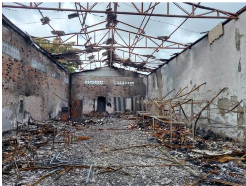
Figura 54: Foco Inicial indeterminado devido à devastação dos materiais combustíveis
