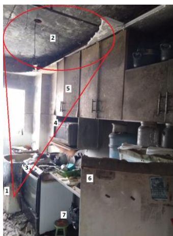
Figura 61: Croqui da propagação do fogo por convecção e irradiação do calor
