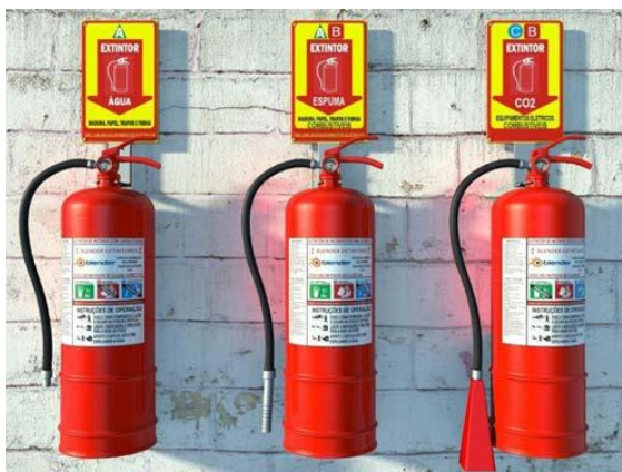
Figura 25: Extintores portáteis
