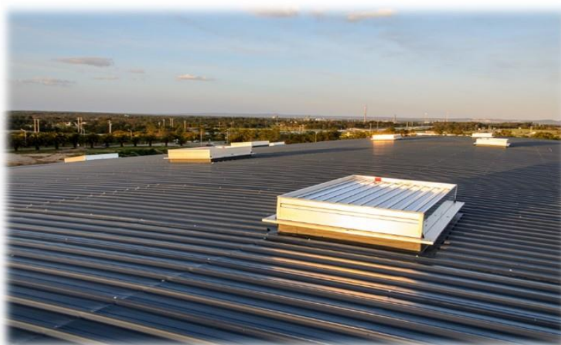
Figura 32: Saídas para extração da fumaça
