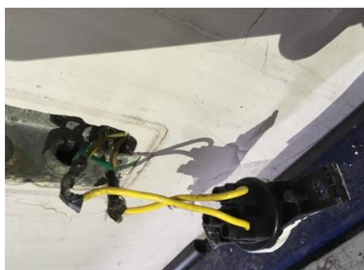
Figura 75: Fiação elétrica intacta
