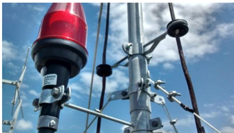
Figura 36: Subsistema de captação de um SPDA
