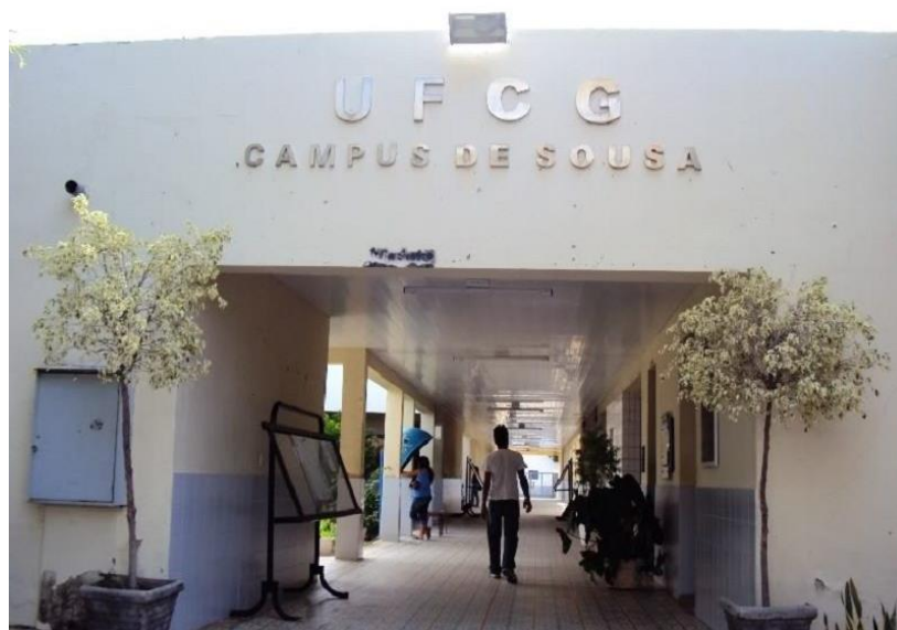
Figura 9 – Foto da entrada do antigo prédio da UFCG – Campus Sousa- PB
