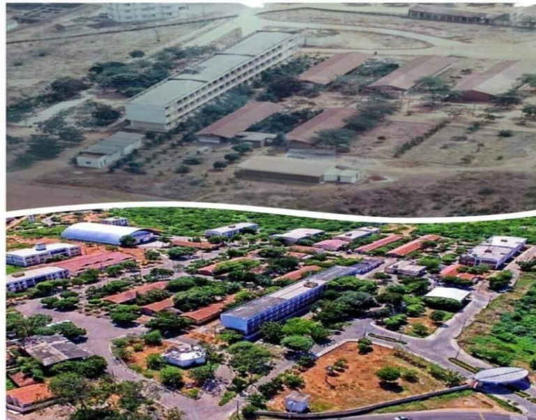
Figura 10 – Vista aérea do Centro de Formação de Professores – Cajazeiras – PB (na parte superior como Campus da UFPB (anos 80). Abaixo, vista atual como campus da UFCG.
