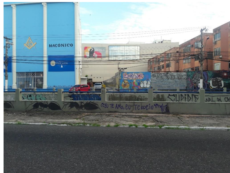
Figura 63: produção gráfica na mureta do canal da Tamandaré, na Avenida Almirante Tamandaré, Bairro da Campina. Capturada em 10 de outubro de 2018, pelo autor.
