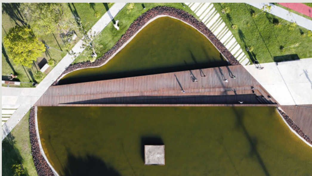
FIGURA 14: PONTE DO PARQUE FUTURO. FONTE: JOÃO SARTURI, ARCHDAILY, 2021.
