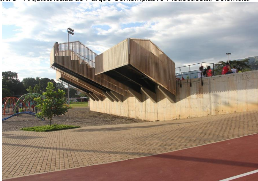
Figura 8 - Arquibancada do Parque Contemplativo Piedecuesta, Colômbia.
