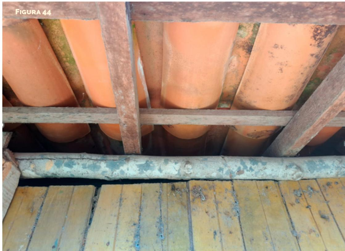
FIGURA 44: DETALHE DO MADEIRAMENTO DO TELHADO, ASSIM COMO APOIO DE CAIBROS PARA SUSTENTAÇÃO DA ESTRUTURA
