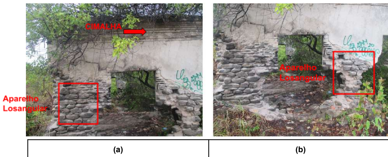
Imagem 19: Vista da Fachada Sudoeste
