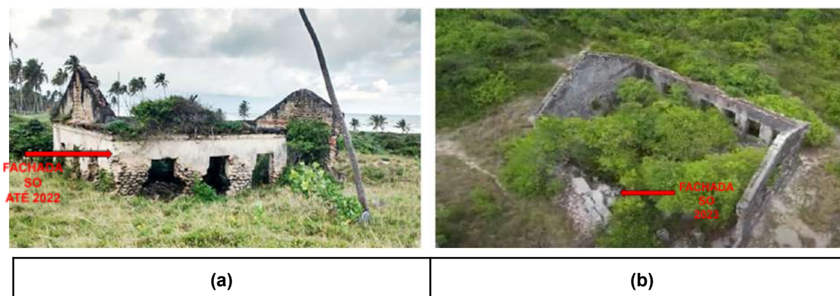
Imagem 16: Alvenaria posterior da Fachada Sudoeste (SO) do Leprosário da Praia do Francês.
