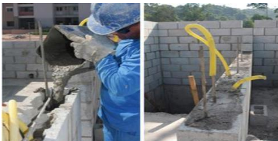
Figura 3 - Execução de Graute na alvenaria.
