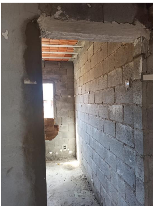
Figura 20 - Serviço das dimensões das portas internas finalizado.
