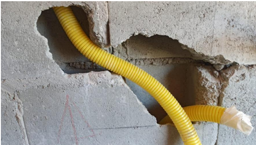
Figura 13 - Quebra de alvenaria na casa número 2.
