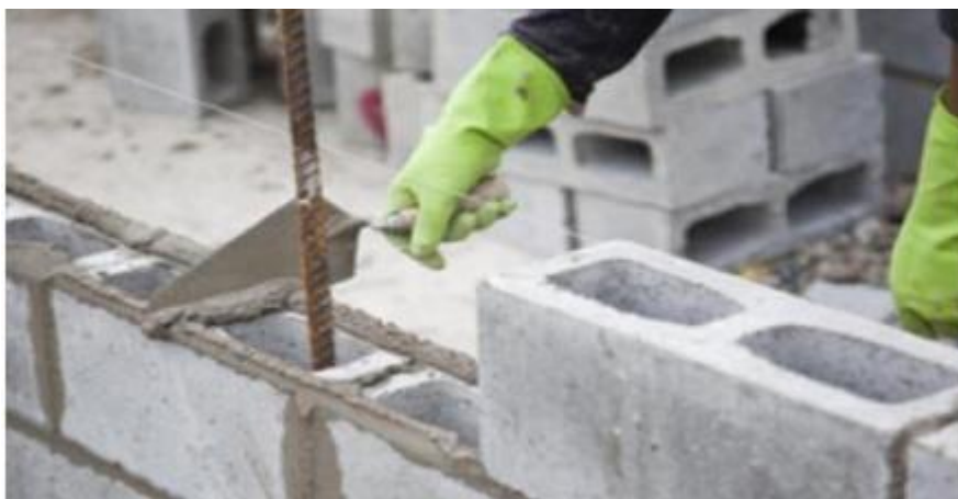
Figura 4 - Argamassa de assentamento
