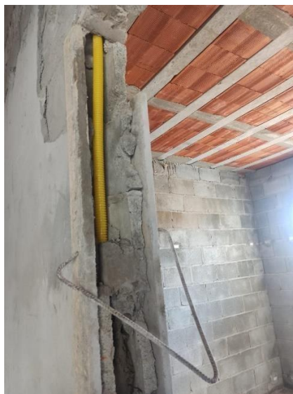
Figura 21 - Serviço das dimensões das portas internas em execução.
