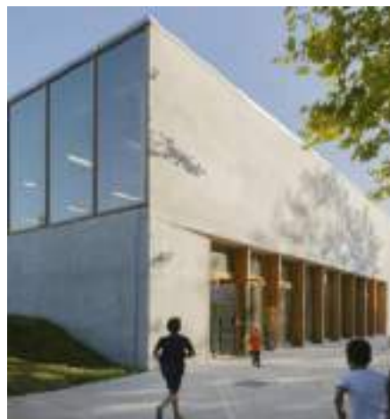
Figura 24 - Foco nos elementos da fachada.
