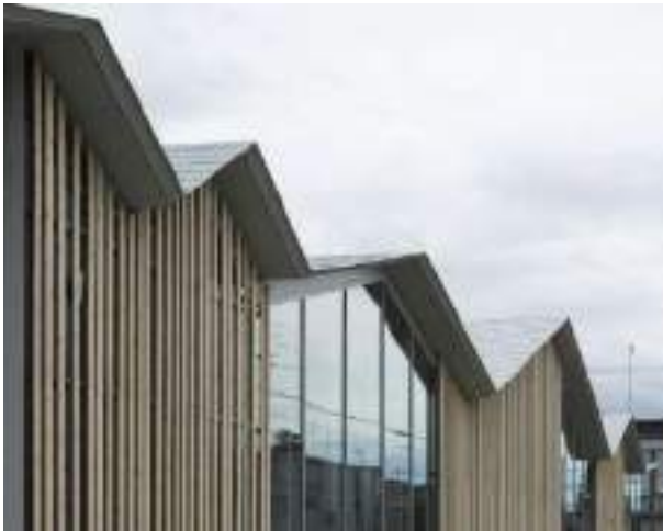
Figura 7 - Fachada do edifício com foco nos painéis wainscot.
