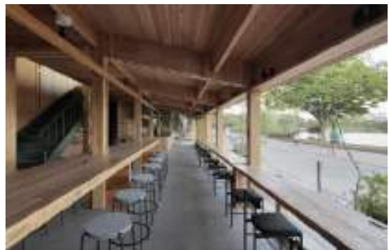
Figura 2 - Parte interna do edifício que mostra sua estrutura em madeira
