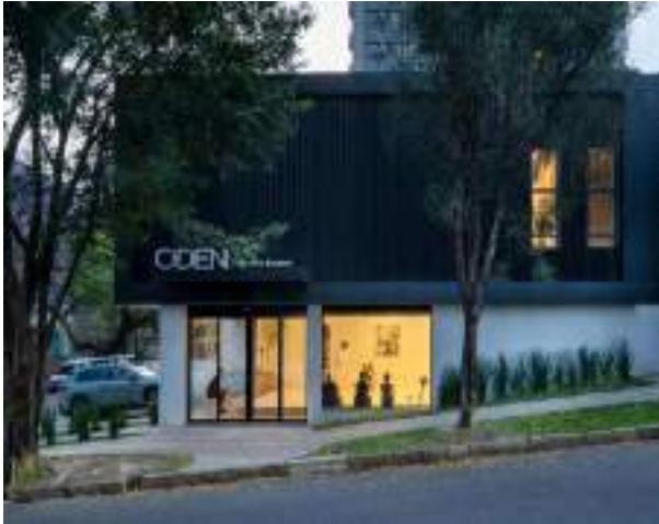
Figura 13 - Fachada do edifício.
