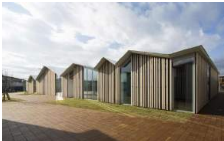
Figura 6 - Fachada do edifício.
