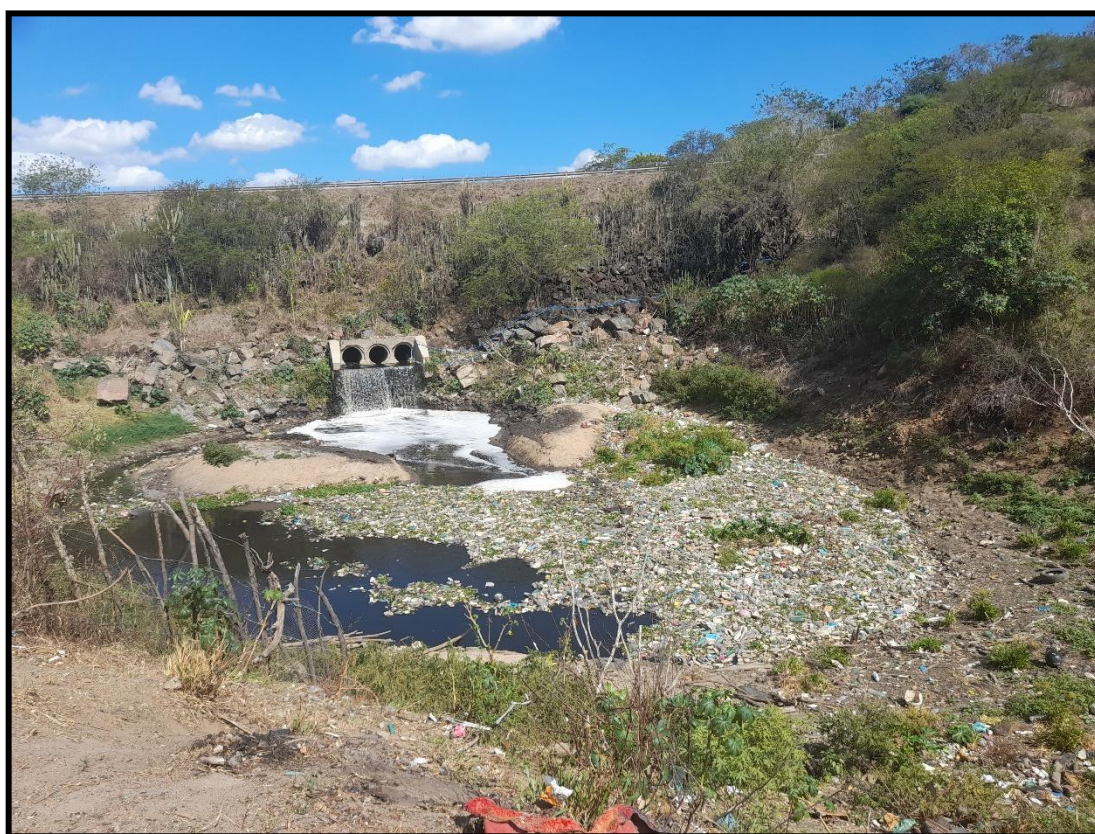
Figura 47- Acúmulo de resíduos carregados pelo sistema de macrodrenagem urbana
