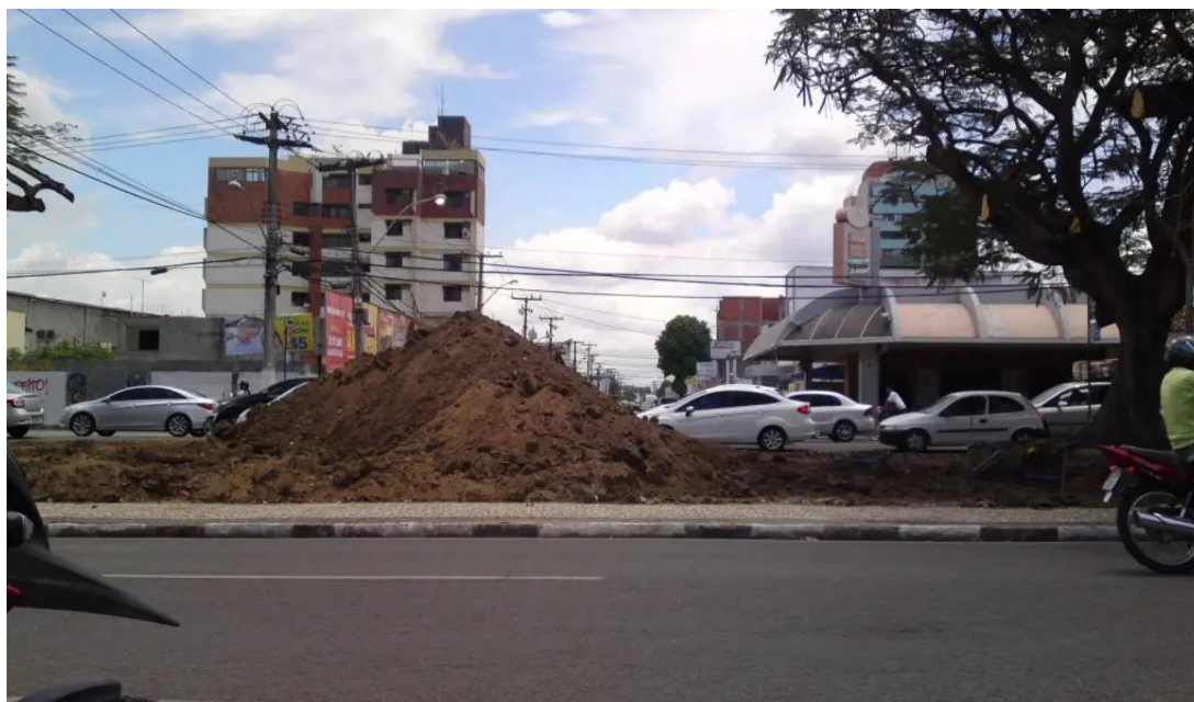
Figura 43- Derrubada de árvores para a construção do corredor BRT
