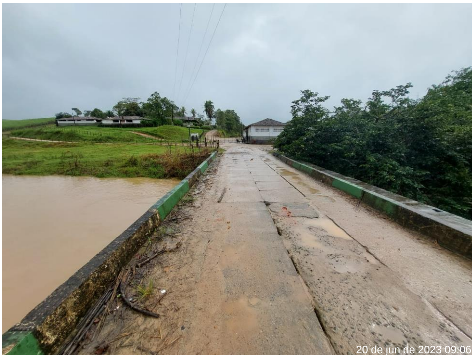
Foto 05: Ponte travessia Jacuípe – AL para Água Preta - PE
