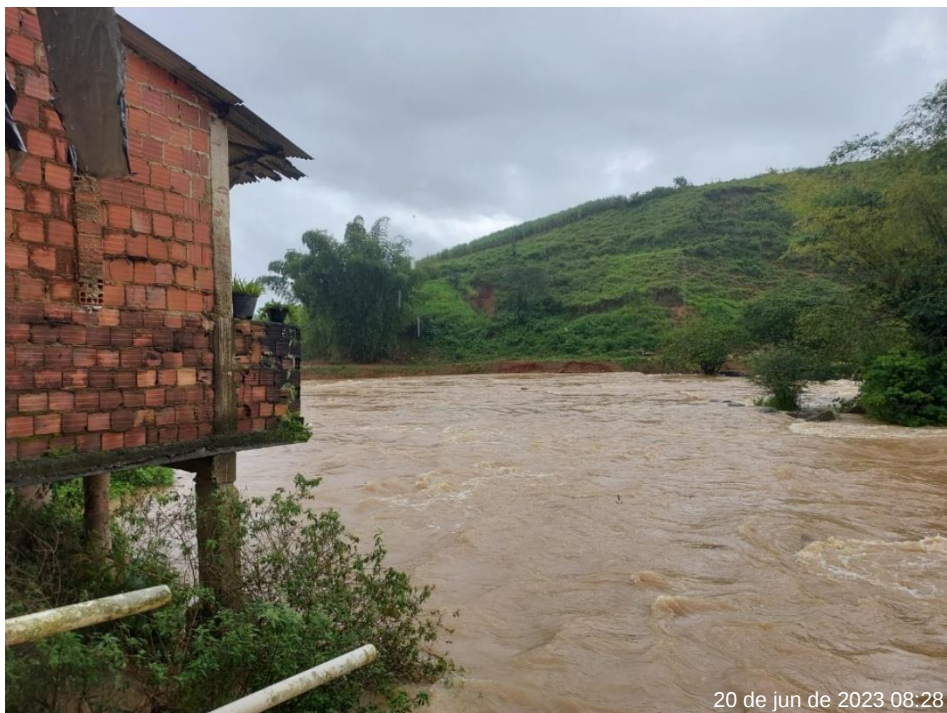
Foto 07: Moradia em local de alto risco ambiental, Jacuípe - AL
