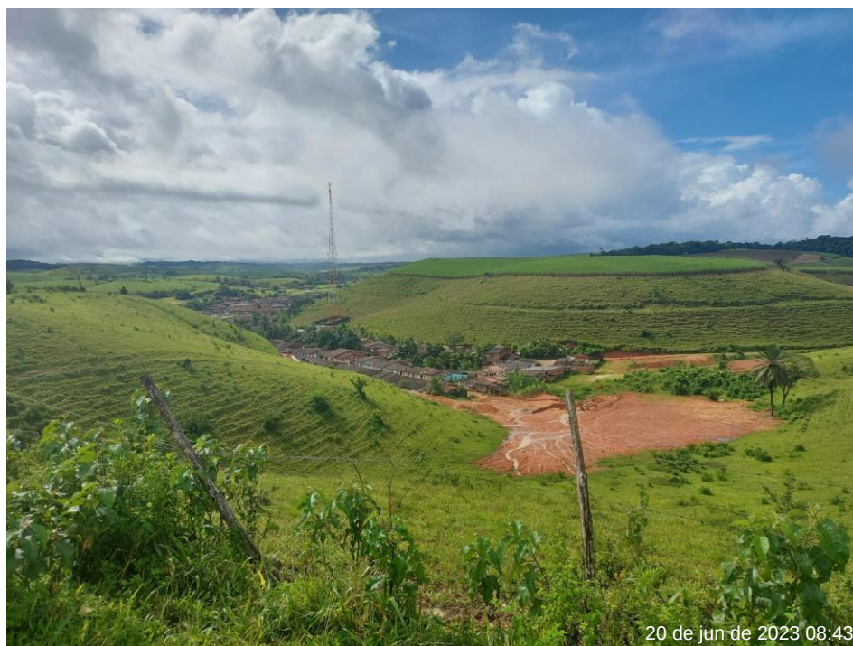
Foto 09: Área sujeito a erosão superficial, Jacuípe - AL
