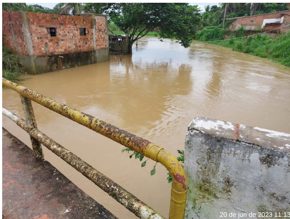
Foto 10: Moradias em locais de alto risco ambiental, Colônia Leopoldina - AL
