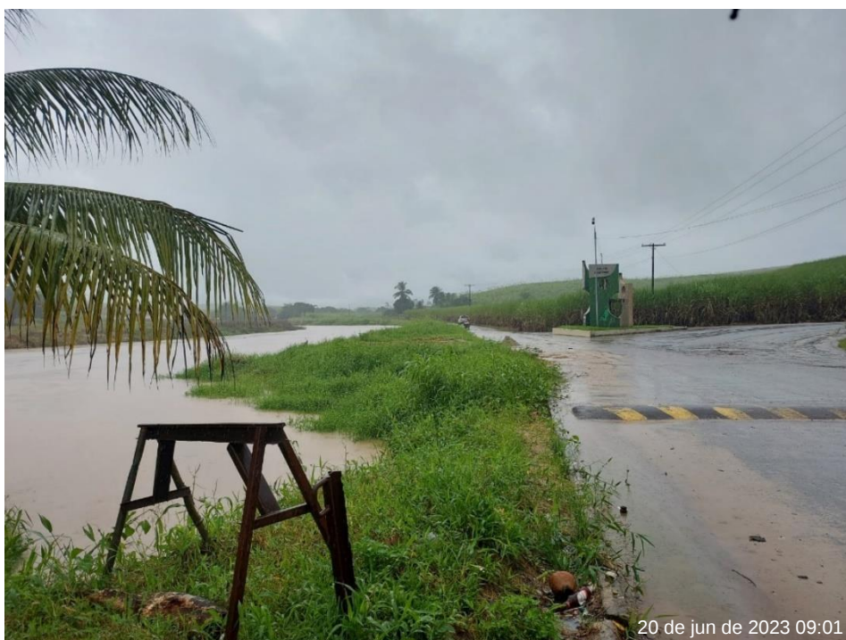
Foto 06: Pista de acesso ao Município de Jacuípe - AL
