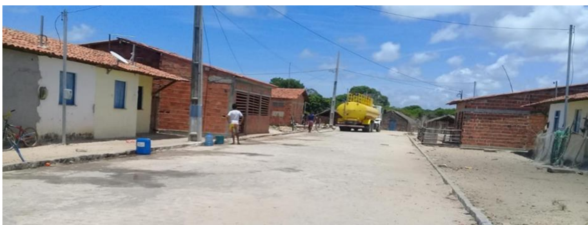
Figura 24 – Rua pavimentada no povoado Saramém, em Brejo Grande/SE.
