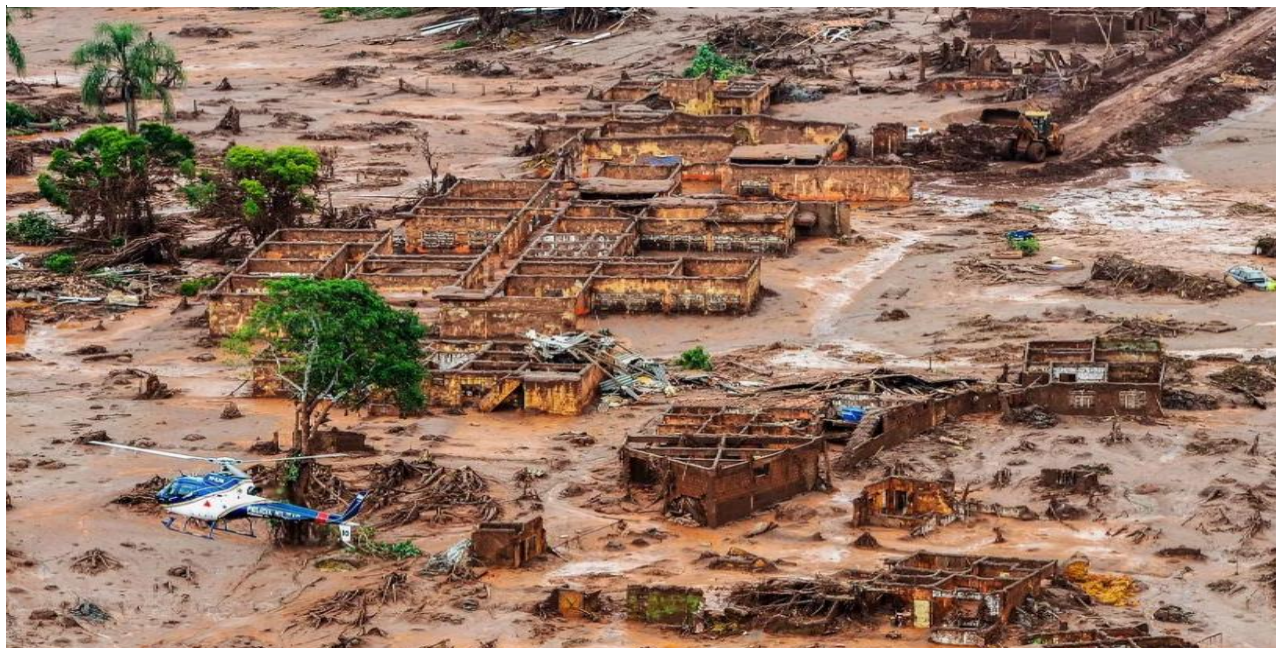
Figura 1. Brumadinho (MG) - Rompimento da barragem de rejeitos da VALE - 2019
