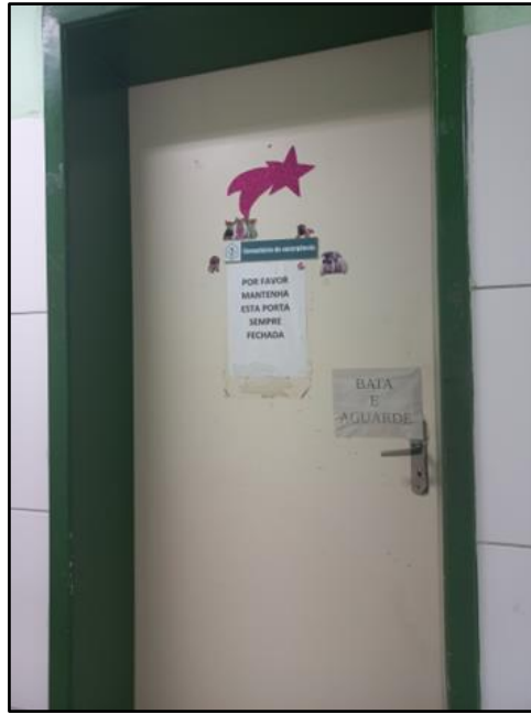
Figura 5: Sala destinada para atender pacientes de caráter emergencial, devido ao estado que se encontravam, não foi possível fotografar o interior da sala. Fonte: Arquivo pessoal, 2024.
