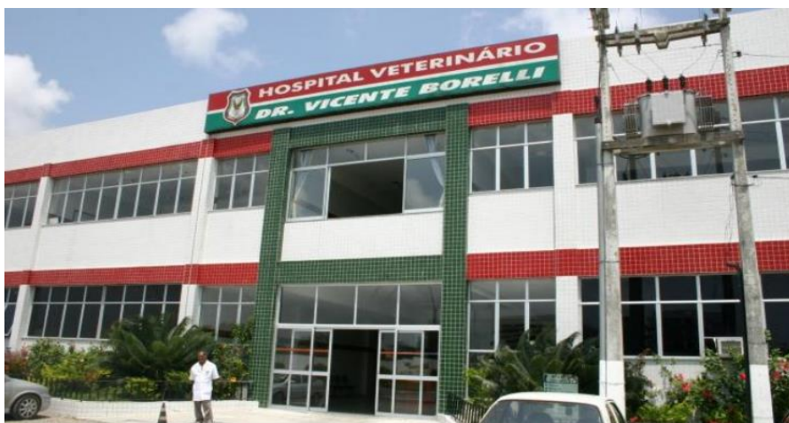
Figura 8: Fachada do Hospital Veterinário Escola Vicente Borelli. Fonte: Google imagens.
