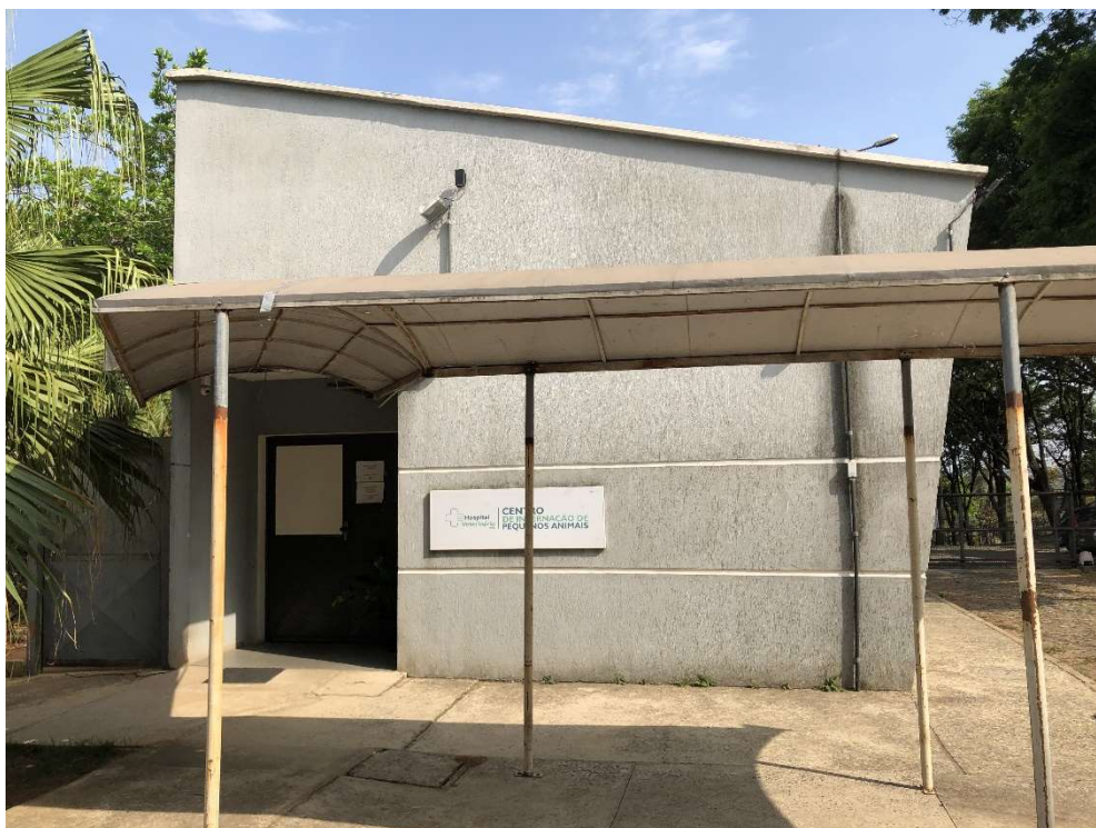
Figura 6: Fachada da internação de cães e gatos do HV-UFMG. Fonte: Cedida por Emilly Aragão, 2024.
