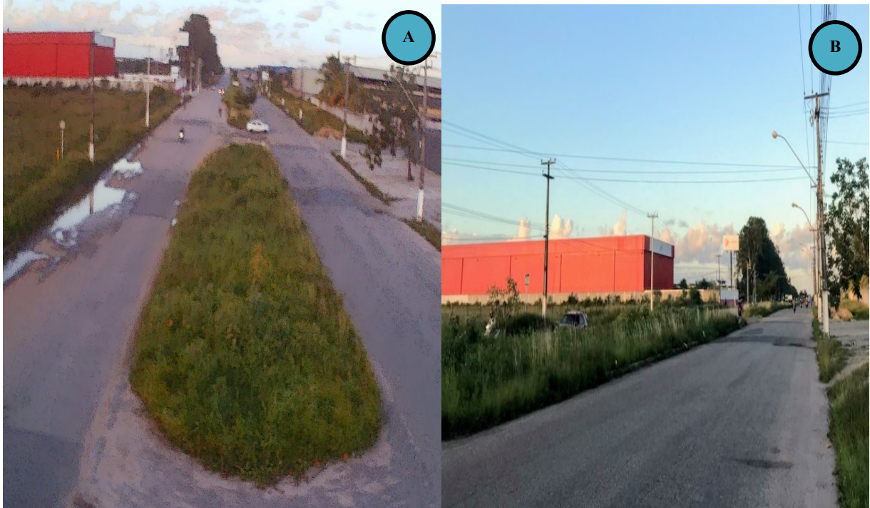
Figura 14 – Centro do limite Leste – Avenida Estrutural B.
