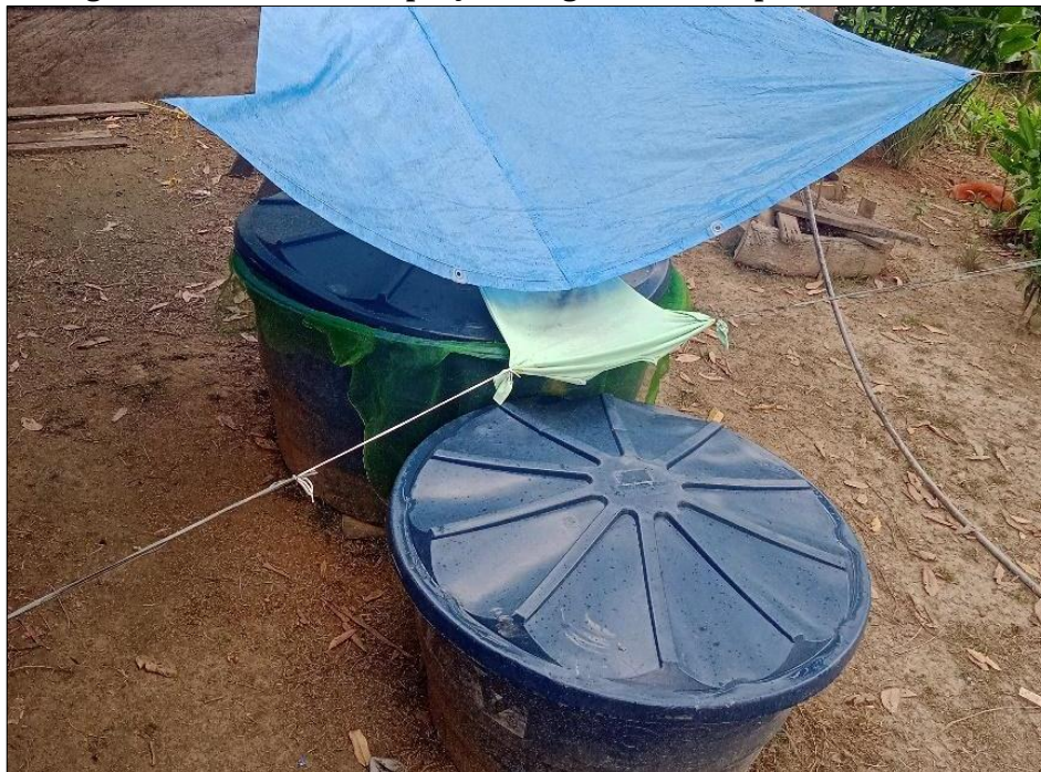
Figura 11 - Sistema de captação de água da chuva por comunitários.
