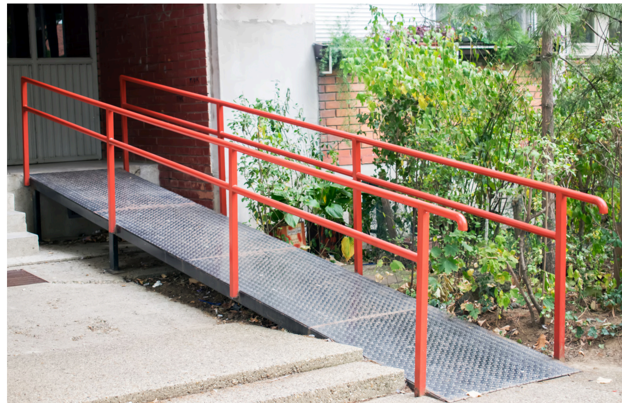
Figura: Rampa para acesso de pessoas com mobilidade reduzida
