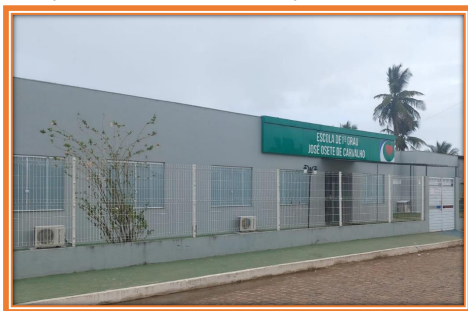
Figura 1: foto da fachada da Escola de 1º grau José Osete de Carvalho
