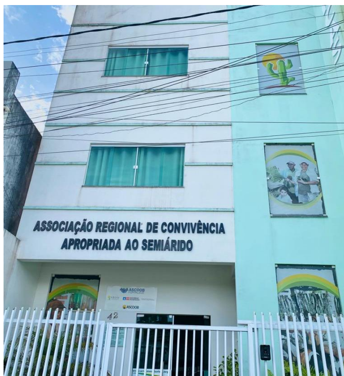
Figura 07 – Prédio da ARCAS e Sede do CODETER, Cícero Dantas, Bahia, 2022
