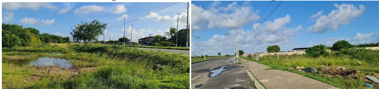
Figura 39 - Trecho 01-02: Início da Av. Rota de Fuga
