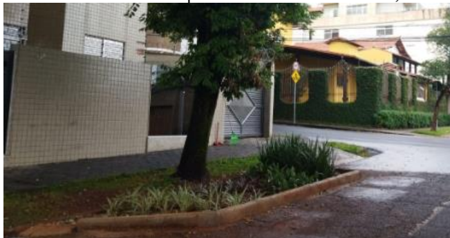
Figura 19 - Jardim de chuva implantado em Belo Horizonte, Minas Gerais
