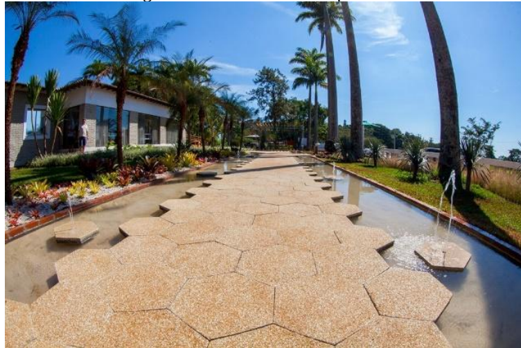
Figura 7 - Piso drenante em passarela
