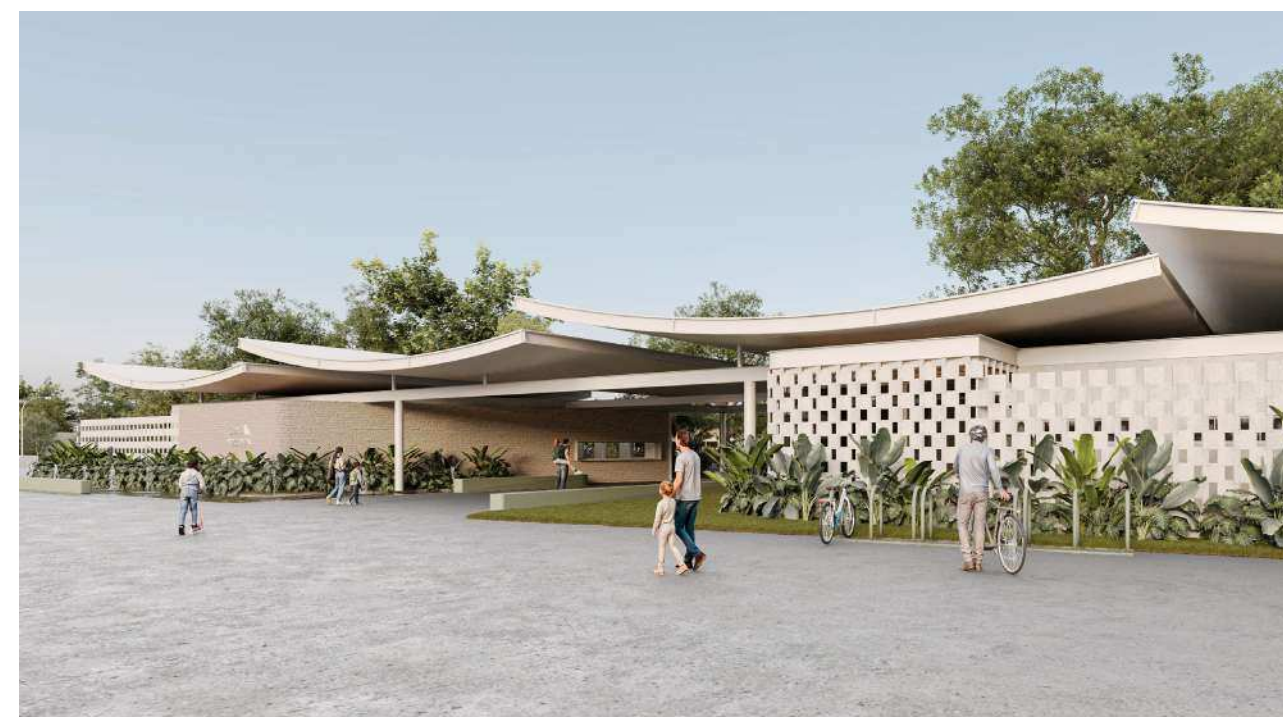
Figura 56 - Fachada frontal. Fonte: Desenvolvido pelo autor, 2024.
