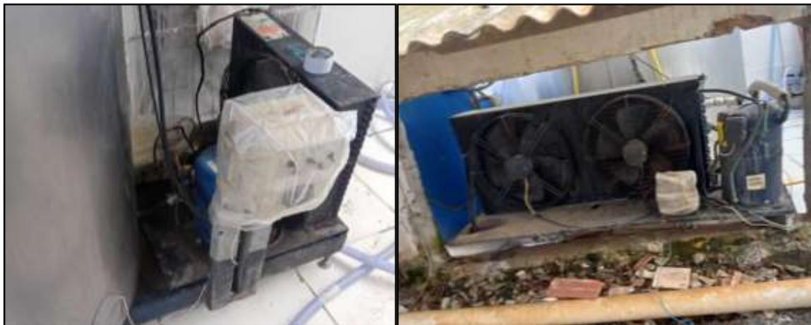
Figura 9: Motores elétricos para refrigeração do leite (9a) espaço interno (9b) espaço externo.
