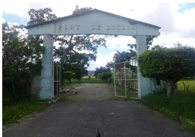
Figura 9 - Entrada do Porto de Aguada. Fonte: Elaboração própria, 2023.
