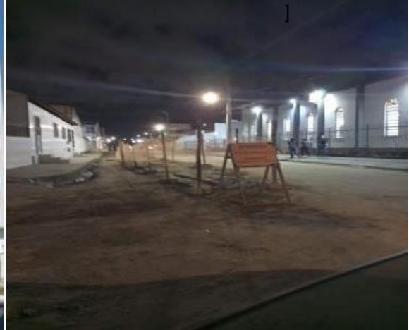
Figura 18 - Obras na rua
