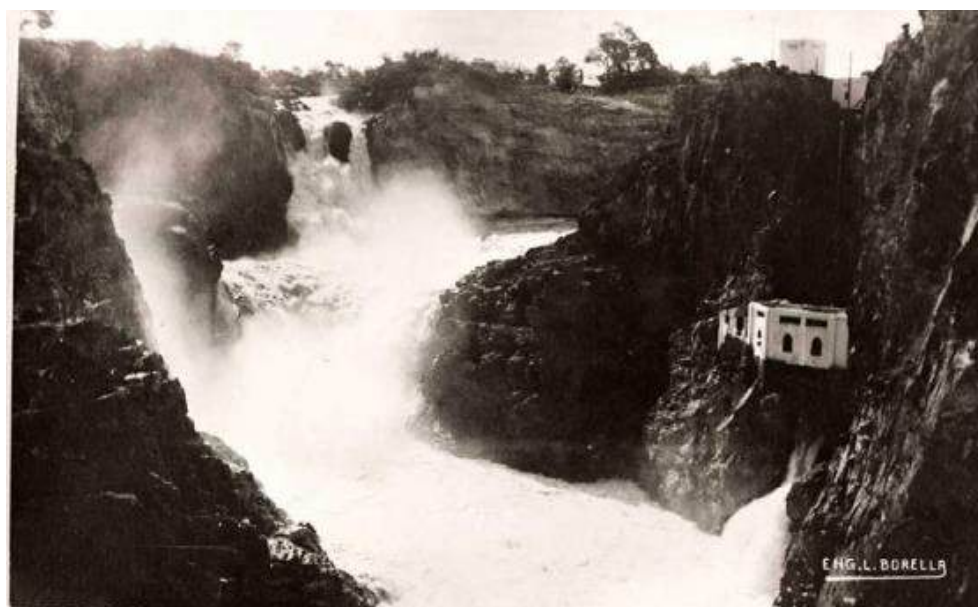
Figura 10 - Usina Hidrelétrica de Angiquinhos
