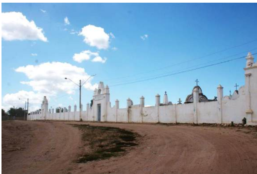
Figura 23 - Acesso à área frontal do cemitério através da ponte sobre o riacho
