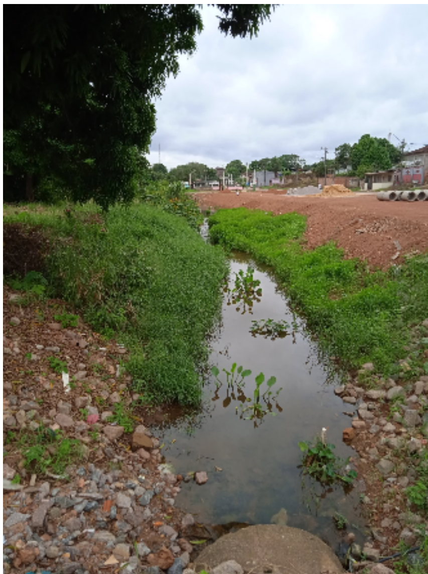
Figura 30 – Igapós transformados em valas de esgoto
