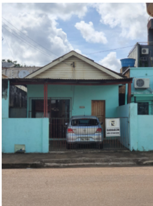
Figura 19 – Preservação parcial da fachada de uma chattel house , no Centro
