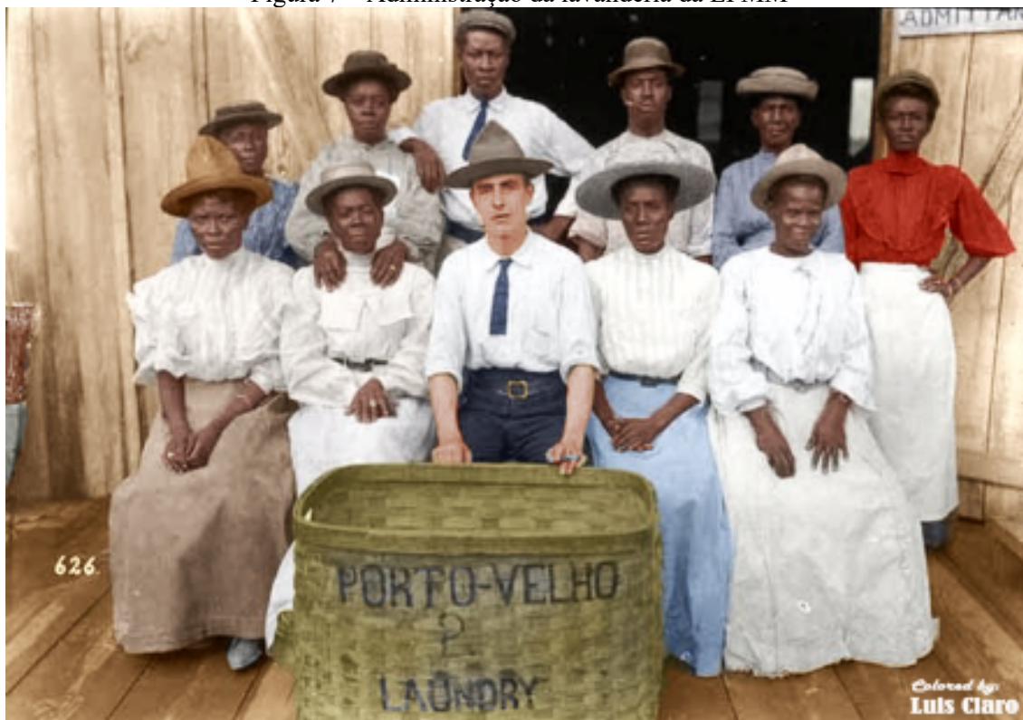
Figura 7 – Administração da lavanderia da EFMM
