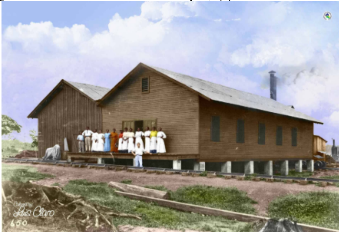
Figura 6 – Externa da lavanderia da Madeira-Mamoré Ry Co., equipe de funcionários e administrador
