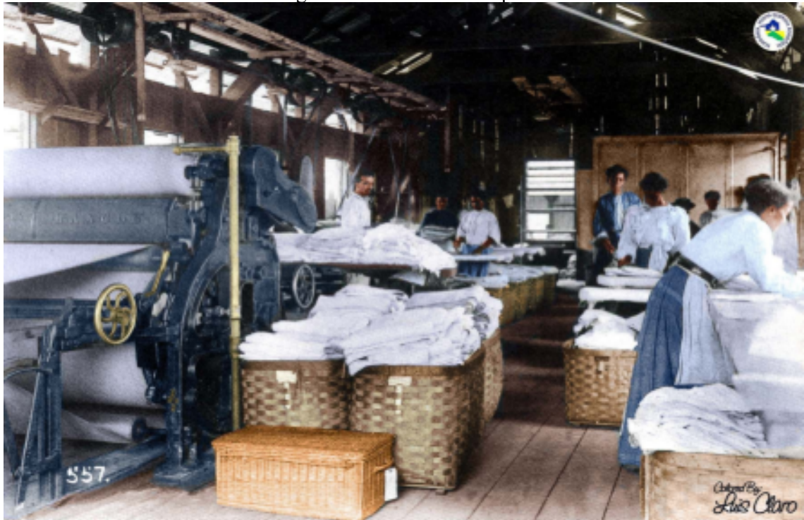
Figura 5 – Lavanderia a vapor
