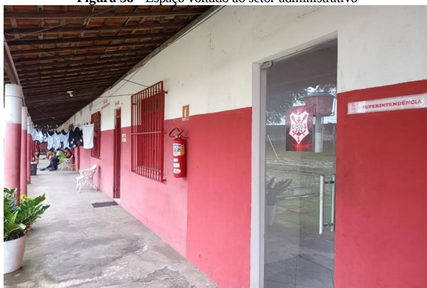
Figura 38 - Espaço voltado ao setor administrativo
