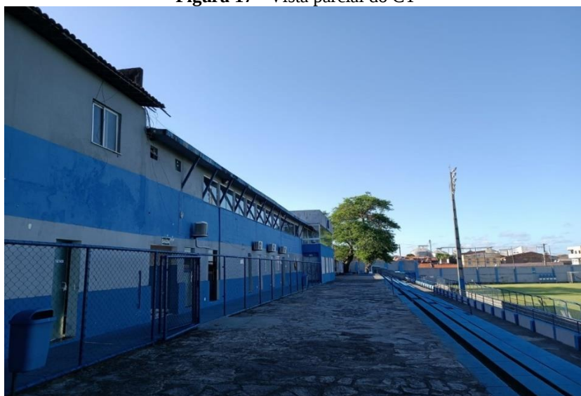
Figura 17 - Vista parcial do CT
