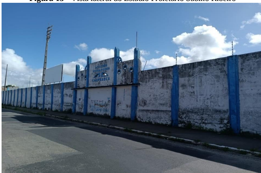
Figura 15 - Vista lateral do Estádio Proletário Sabino Ribeiro
