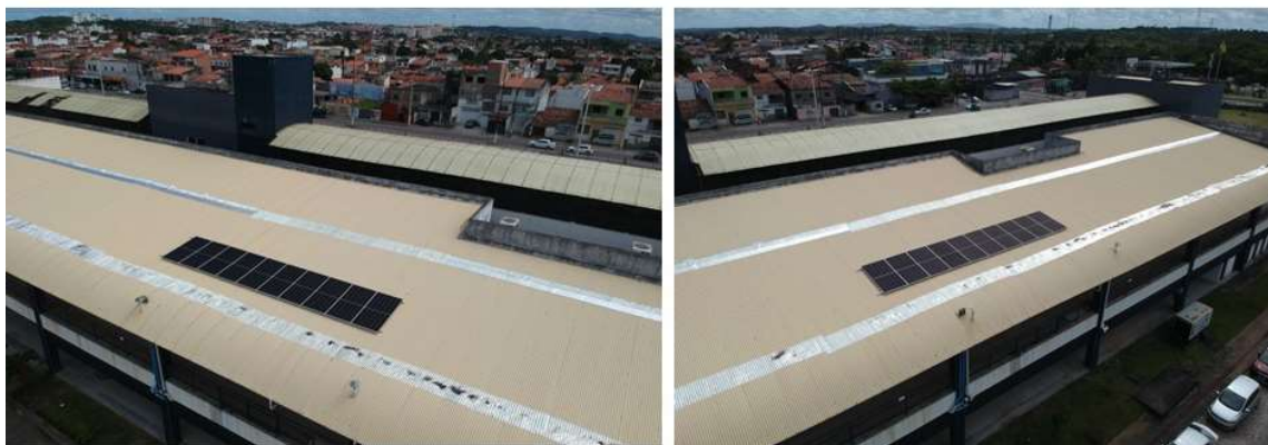
Figura 28 – Placas solares do sistema fotovoltaico de geração de energia renovável.
