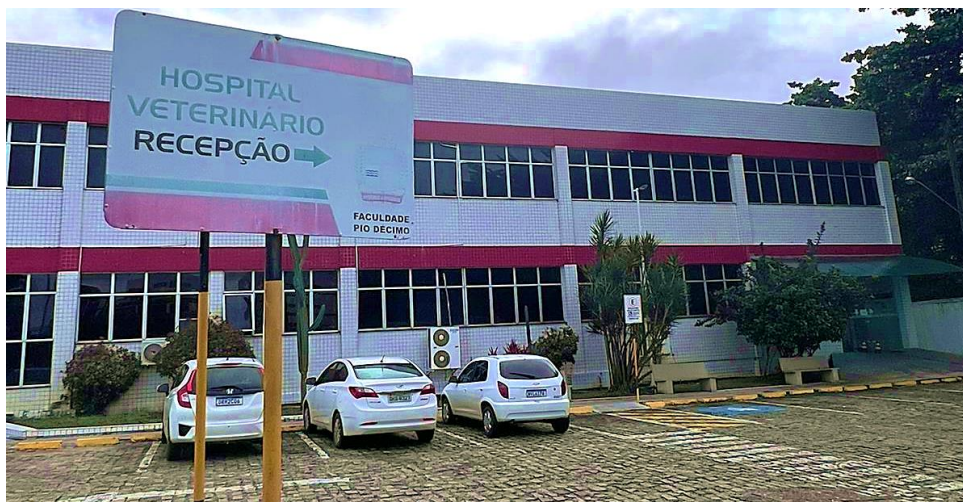
Figura 1 – Fachada do Hospital Veterinário Dr. Vicente Borelli.
