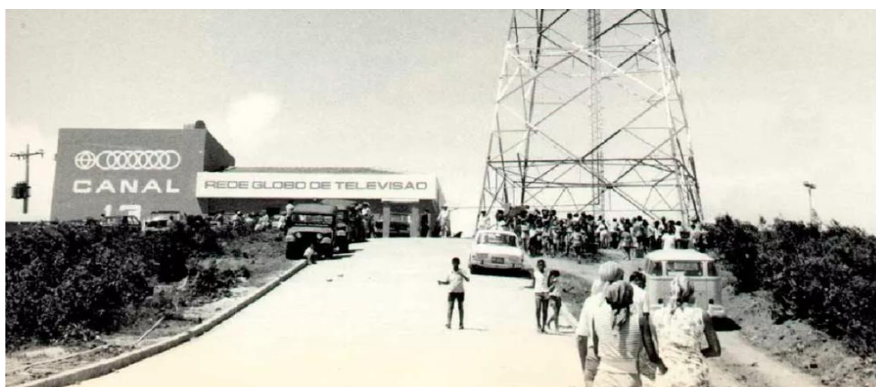
Figura 3 - Torre de transmissão da TV Globo Recife
