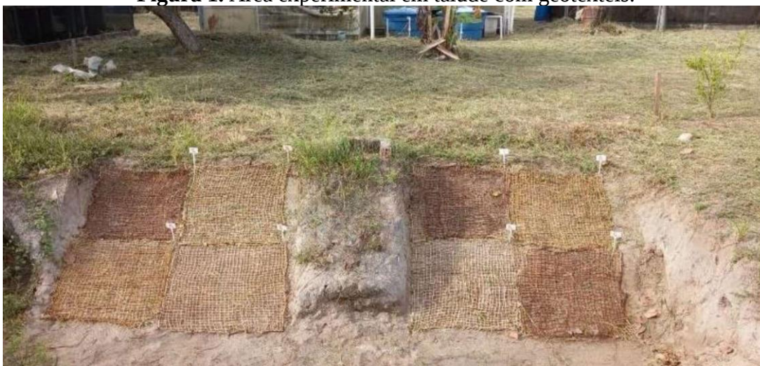
Figura 1. Área experimental em talude com geotêxteis.
