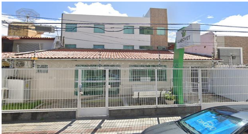
Figura 3 - Fachada do Labovet
