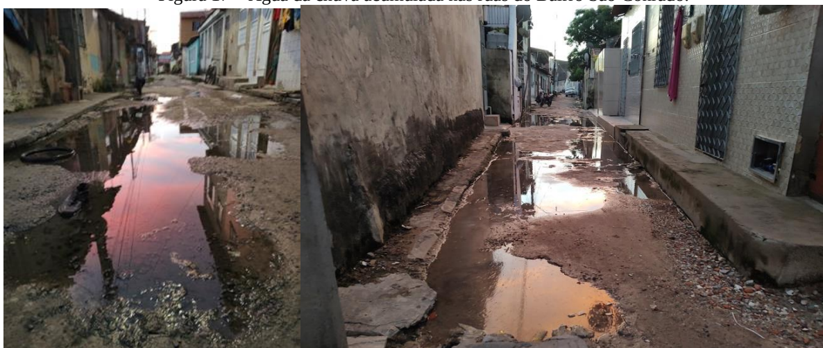
Figura 17 – Água da chuva acumulada nas ruas do Bairro São Conrado.
