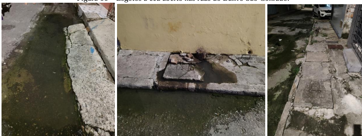
Figura 16 – Esgotos a céu aberto nas ruas do Bairro São Conrado.
