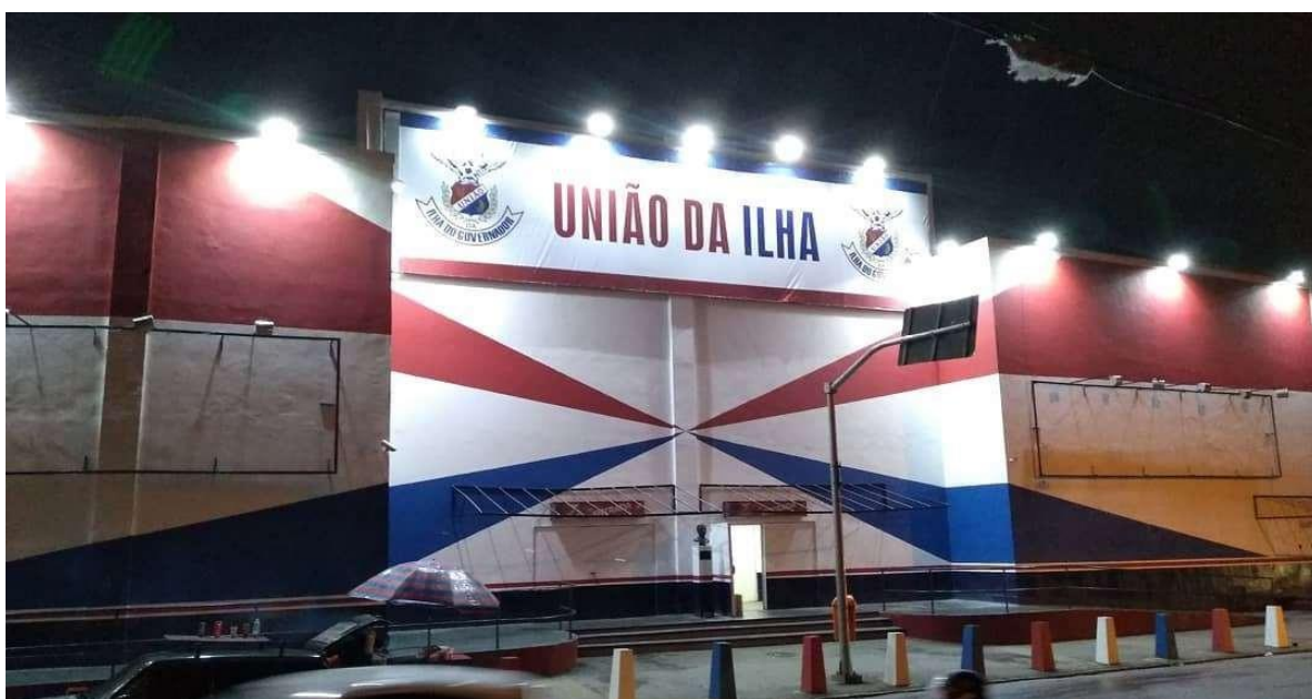
IMAGEM 1: Fachada da Quadra da União da Ilha do Governador
