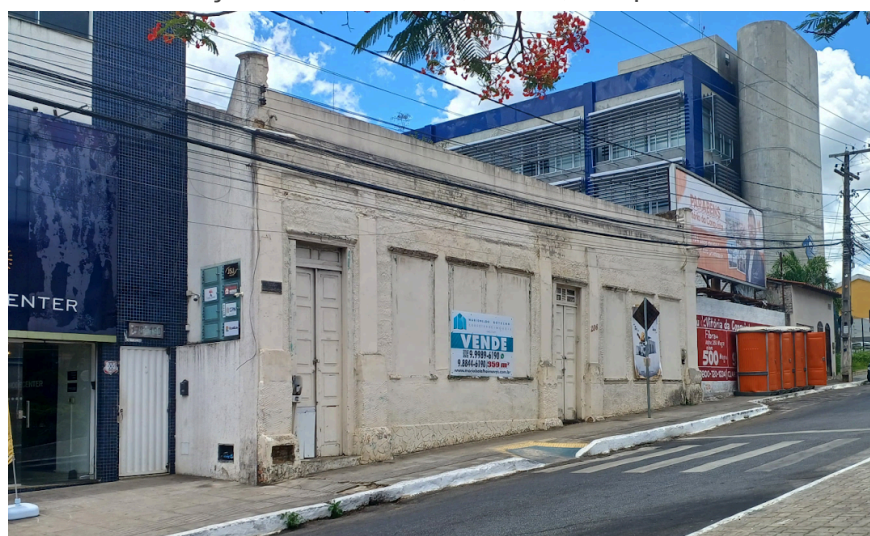
Figura 34 - Imóvel na Praça Tancredo Neves, nº 206, completamente descaracterizado.
