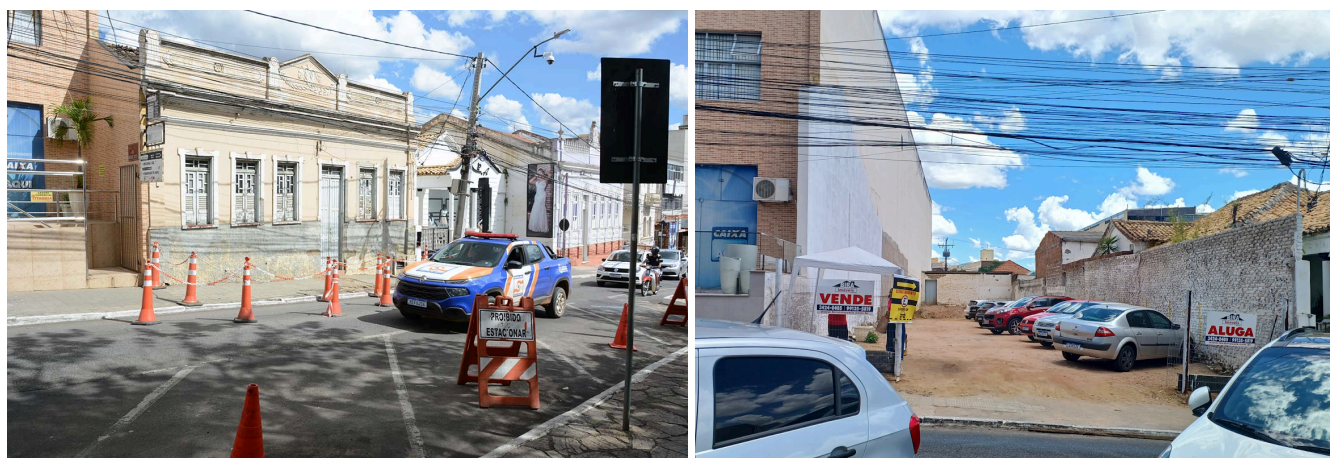
Figuras 33 - Demolição de imóvel histórico na Rua Zeferino Correia, em frente a Praça Tancredo Neves.
