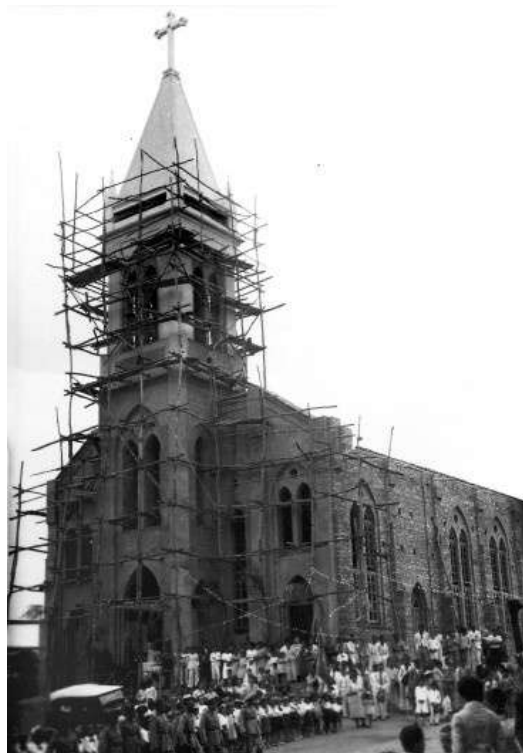
Figura 28 - Construção da Catedral Metropolitana de Nossa Senhora das Vitórias, década de 30 a 40.
