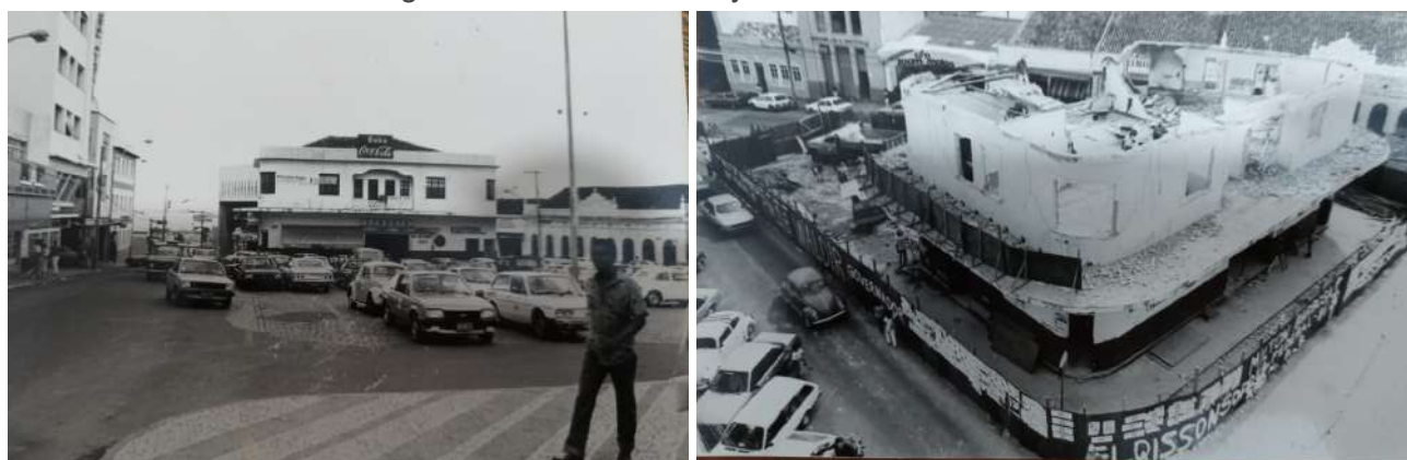
Figura 31 - Edifício Lindoya, demolido em 1987.
