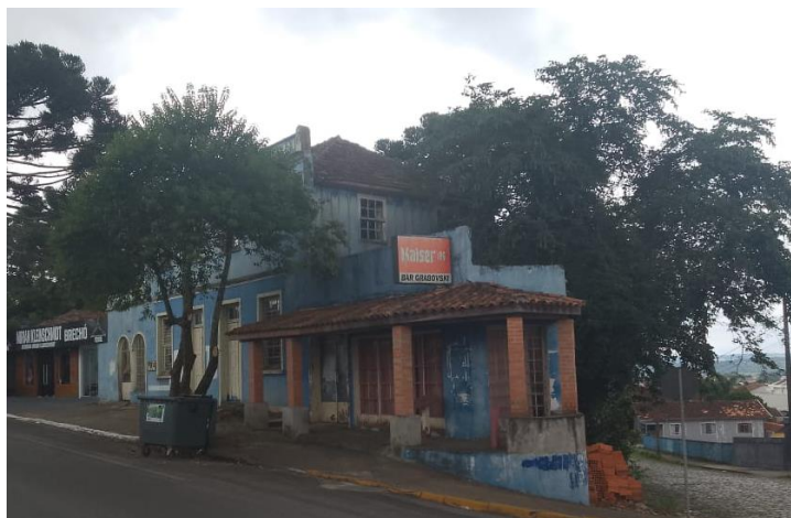
Figura 30. Visão lateral do imóvel.
