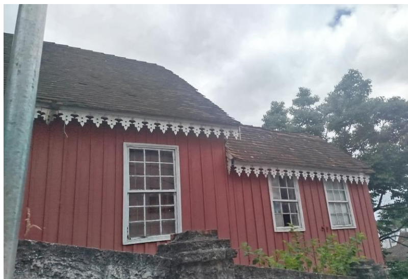
Figura 13. Lambrequins na lateral do imóvel.
