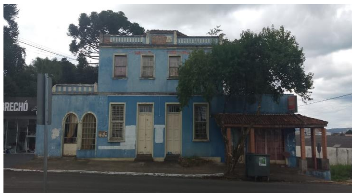
Figura 29. Imóvel comercial com a fachada de alvenaria e estrutura de madeira no Alto de Mafra.
