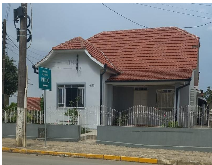
Figura 25. Casa de alvenaria e telhado chanfrado no bairro Vila Nova.
