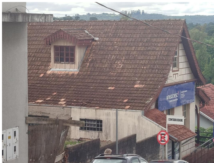
Figura 15. Telhado do imóvel com a presença de lambrequins na lucarna.
