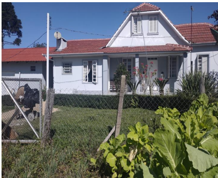
Figura 26. Lateral da casa com o telhado chanfrado e lucarna.
