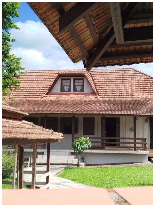
Figura 5. Fachada da casa com telhado chanfrado.
