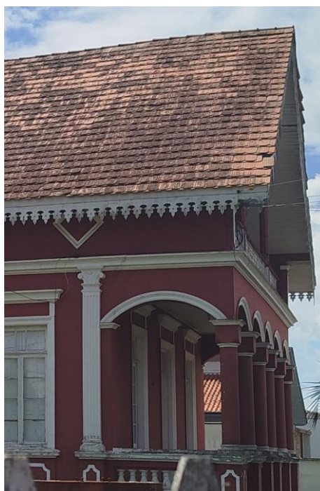
Figura 19. Telhas rabo-de-castor no telhado da Casa Fritz.
