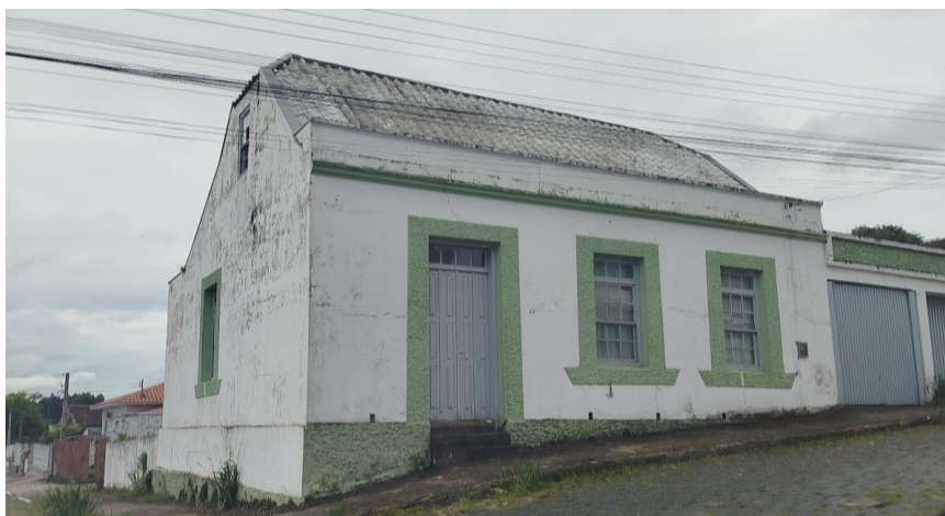
Figura 23. Imóvel de alvenaria com o telhado chanfrado no bairro Vila Ivete
