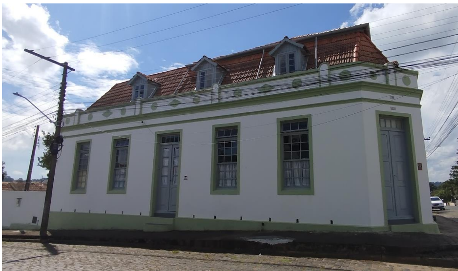
Figura 24. Imóvel de alvenaria no bairro Vila Ivete.
