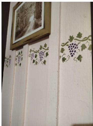
Figura 10. Pintura ornamental das paredes internas da casa do Rio Preto
