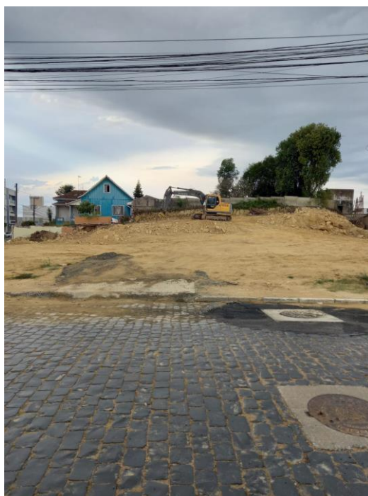
Figura 39. Terreno onde a casa foi demolida.
