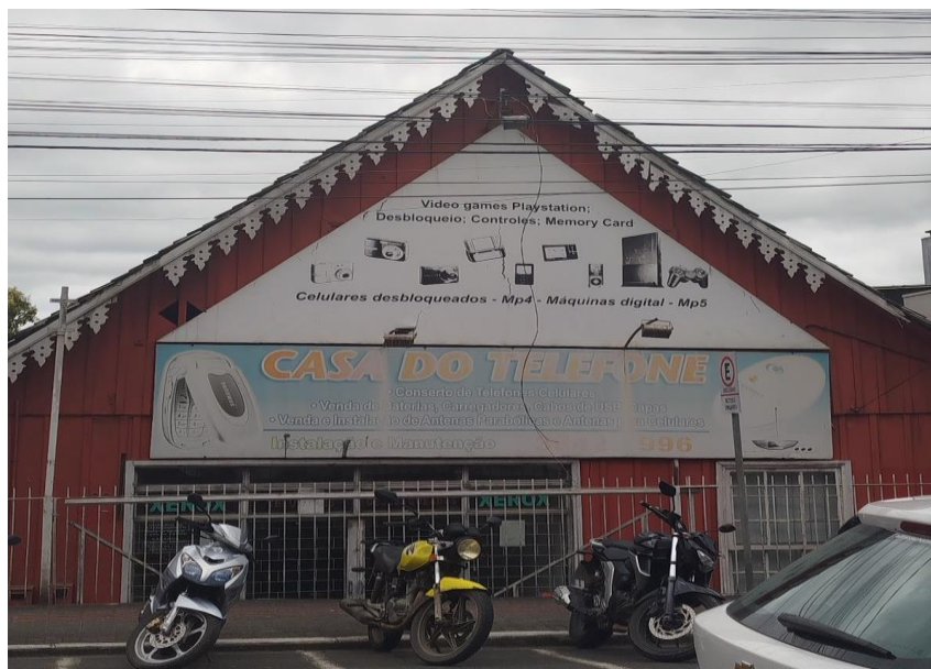
Figura 12. Imóvel de madeira localizado no Centro de Mafra.
