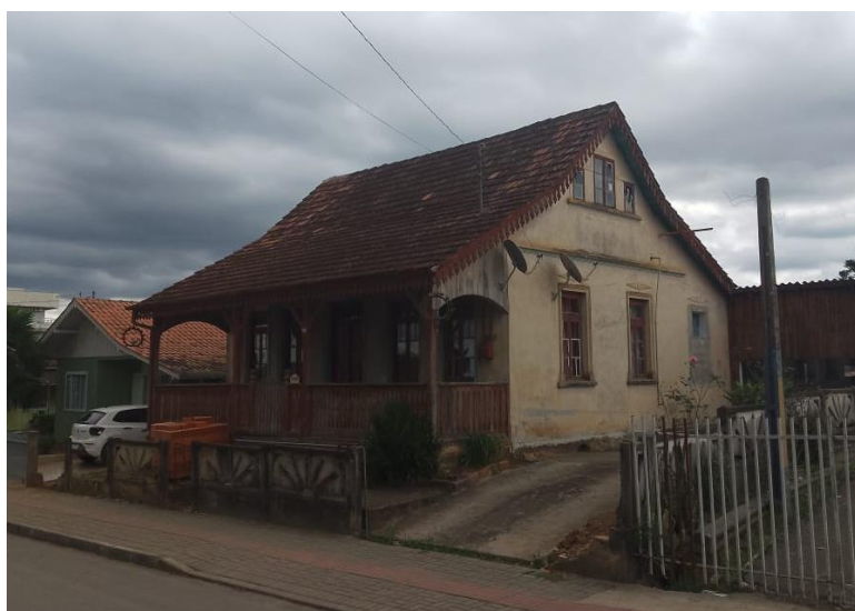
Figura 16. Casa de alvenaria no bairro Vila Nova.
