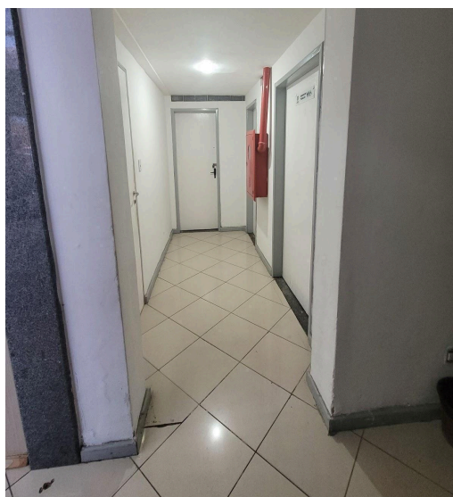
Imagem 16 - Corredor no térreo
