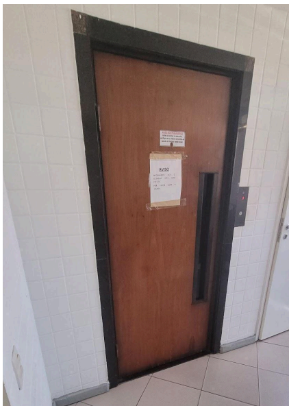
Imagem 17 - Porta do elevador no térreo andar
