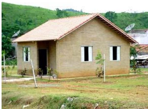
Figura 1. Casa popular construída com tijolos solo-cimento.
