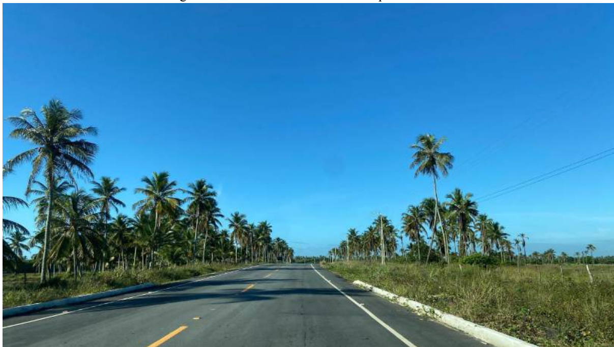
Figura 13 - Trecho da rodovia SE-200 pavimentado
