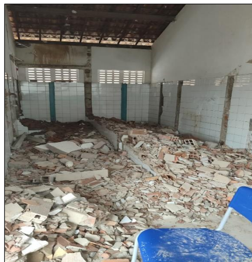
Figura 7 – Banheiros da escola em reforma
