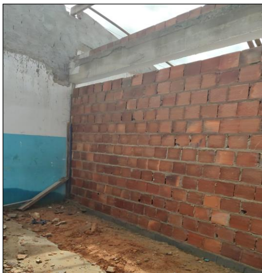
Figura 6 – Sala de aula da escola em reforma
