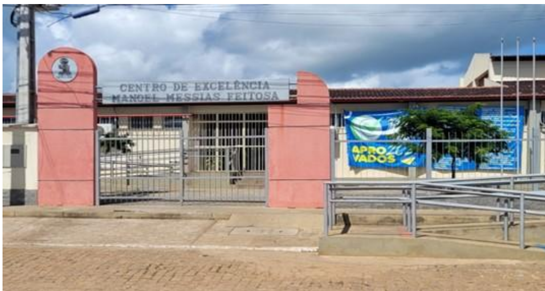
Imagem 2 - Fachada da entrada da escola
