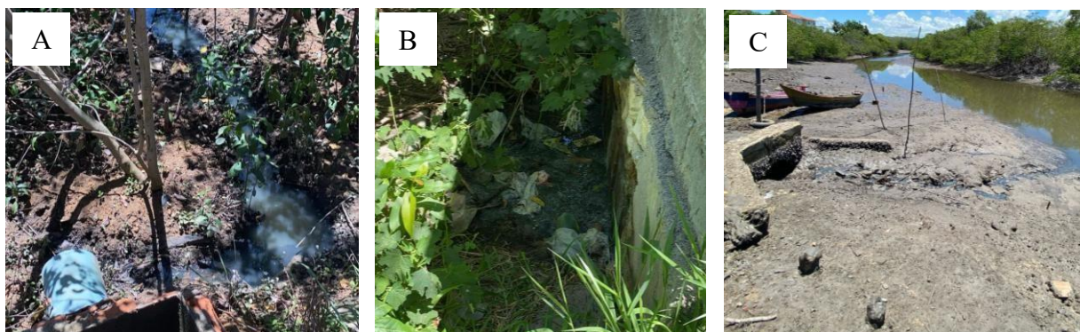
Figura 36: Pontos de descarte irregular de esgoto dentro da ARIE dos Manguezais. Barra dos Coqueiros, SE, A- 12 de março de 2024; B- 31 de janeiro de 2025; C- 12 de março de 2024
