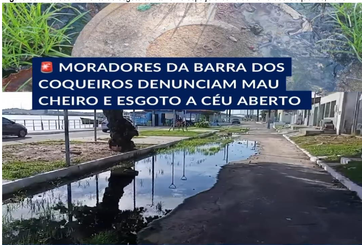
Figura 53: Transbordamento de esgoto sanitário no espaço urbano de Barra dos Coqueiros, 2025.
