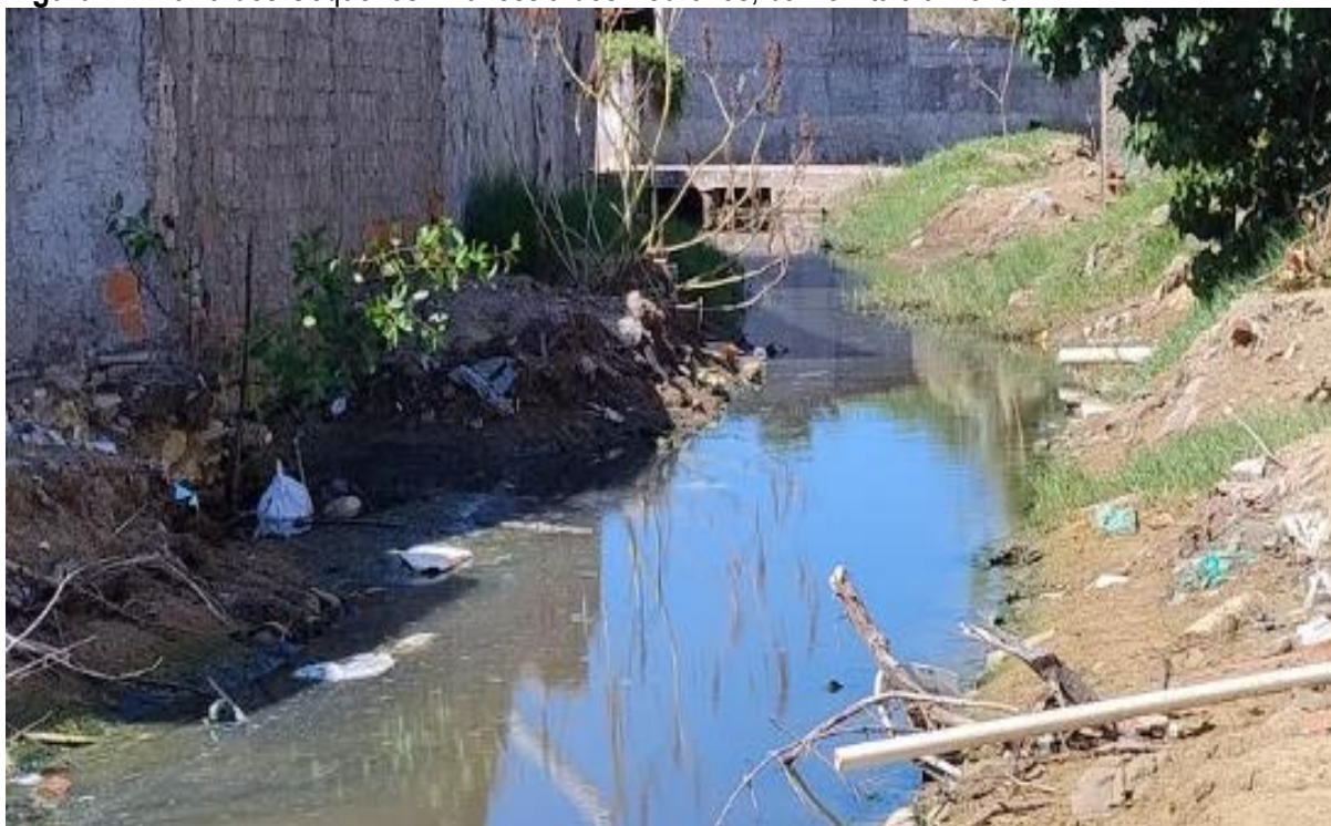
Figura 42: Barra dos Coqueiros -Travessia dos Pedreiros, bairro Atalaia Nova.
