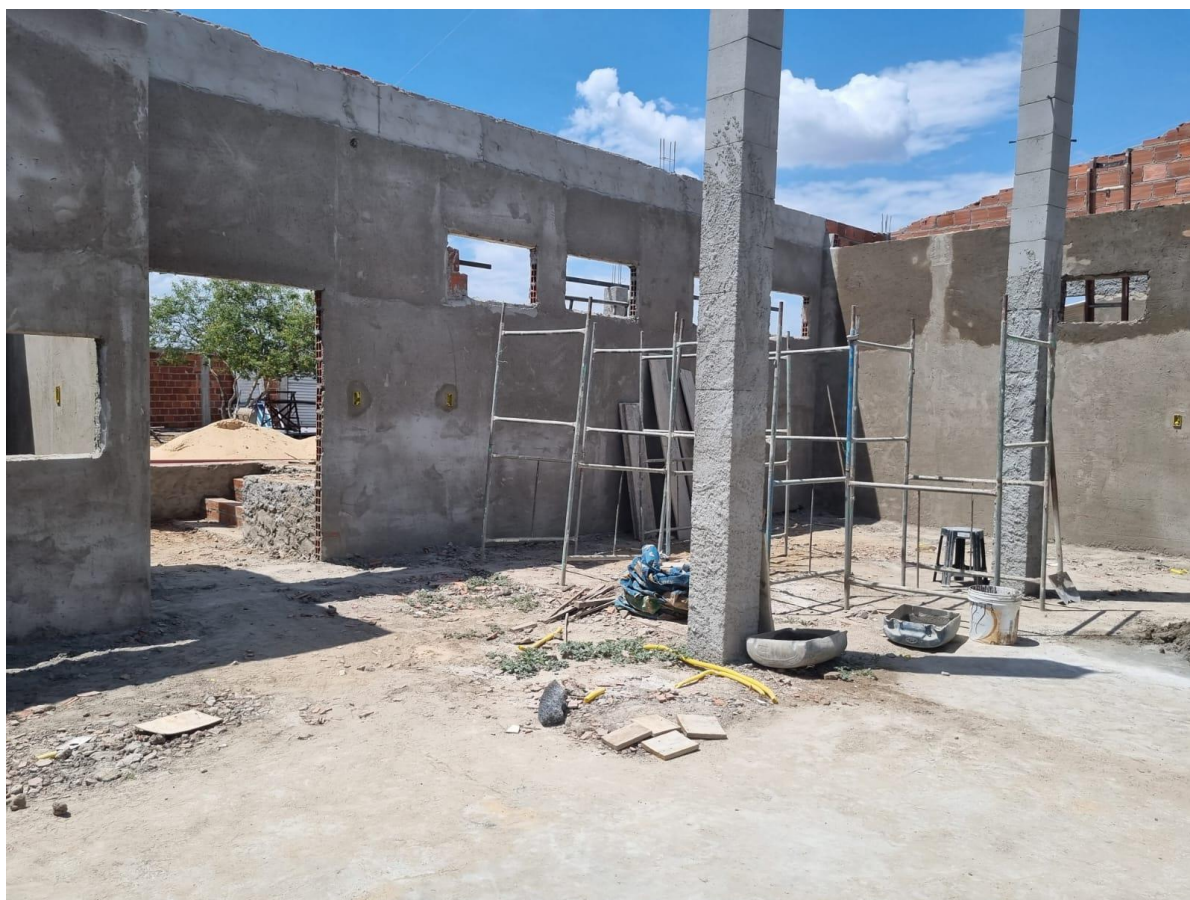
Figura 23: Ambiente interno da construção da fabriqueta de queijo
