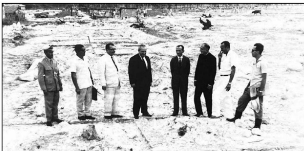
Figura 19 - Autoridades e técnicos na obra de construção do conjunto Agamenon Magalhães em 1952
