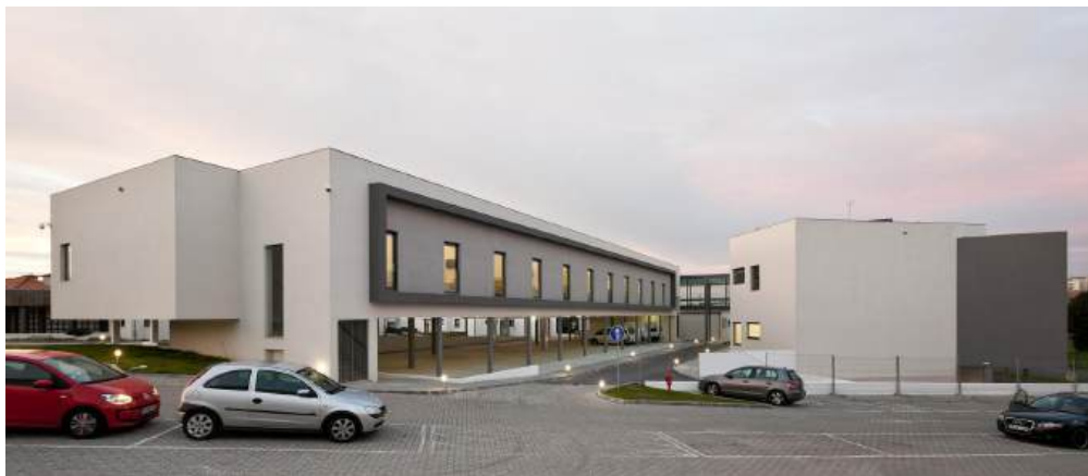
Figura 13: Fachada edifício secundário
