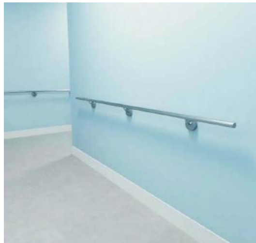
Figura 6: Corrimão no corredor
