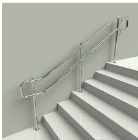
Figura 10: Escada com corrimão acessível
