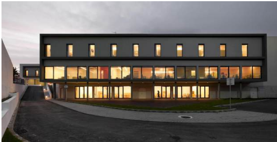
Figura 12: Fachada edifício principal
