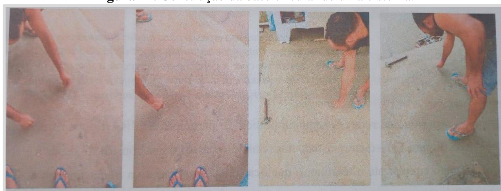
Figura 14. Construção da base circular de uma cisterna.
