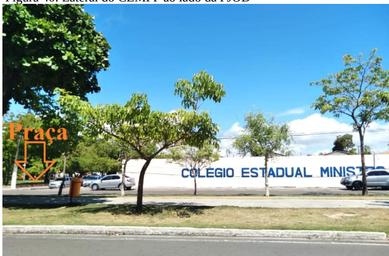
Figura 40: Lateral do CEMPP ao lado da PJOD
